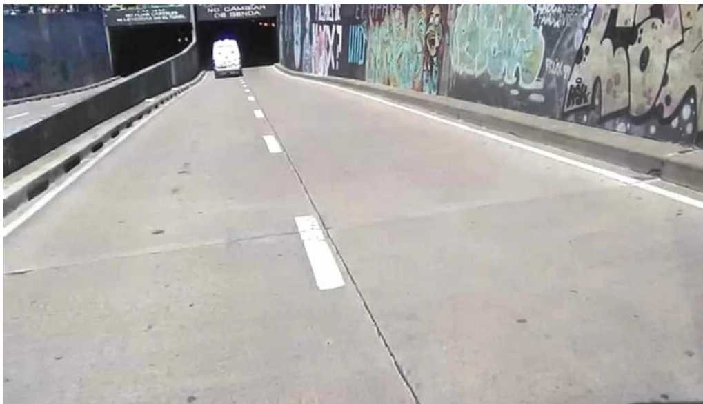
Tunel de montevideo montevideo
