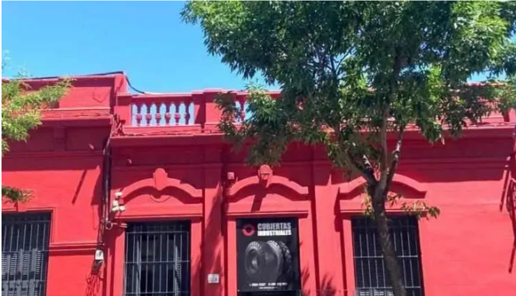
Cubiertas industriales montevideo
