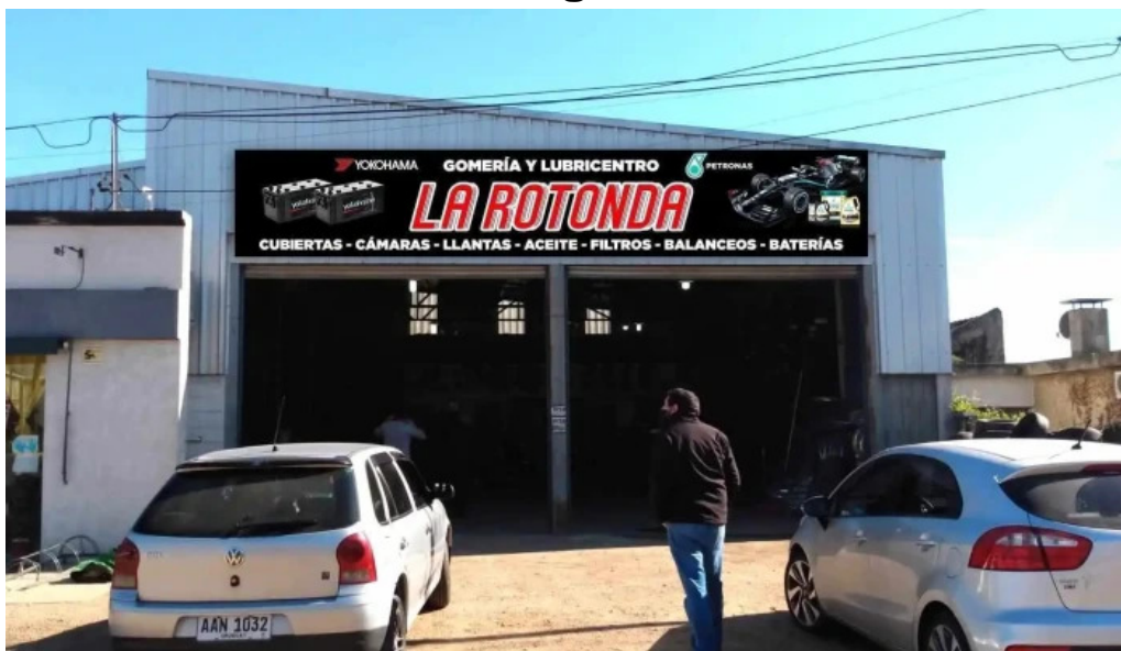
Gomeria la rotonda taller de reparacion de automoviles
