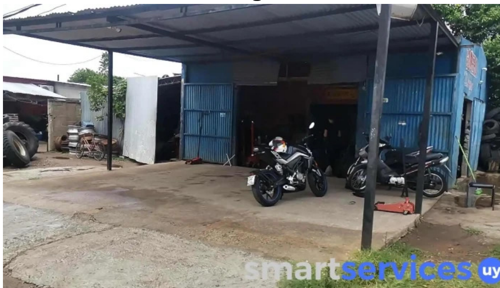
Gomeria taller de reparacion de automoviles
