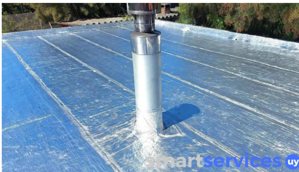
Mr impermeabilizaciones interior
