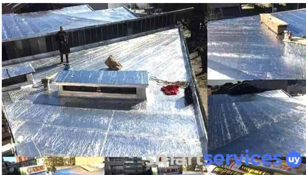
Mr impermeabilizaciones las piedras
