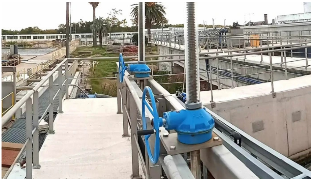
Planta potabilizadora de aguas corrientes ose sitio web
