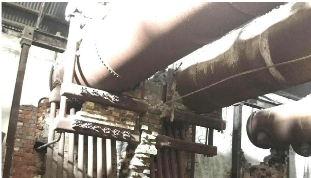
Planta potabilizadora de aguas corrientes ose como llegar
