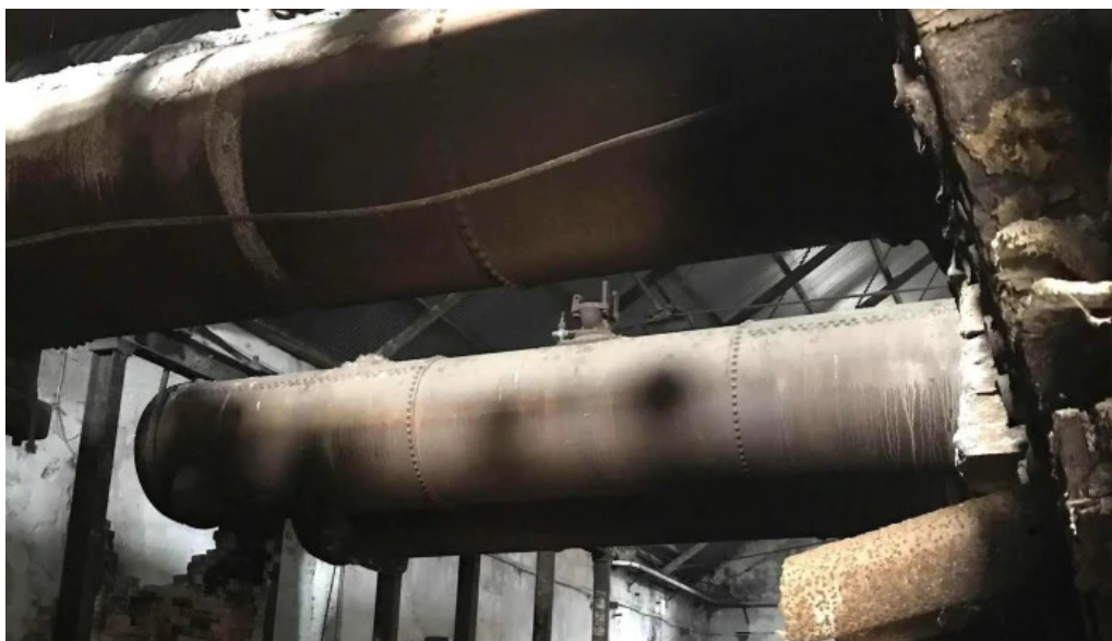
Planta potabilizadora de aguas corrientes ose puntaje
