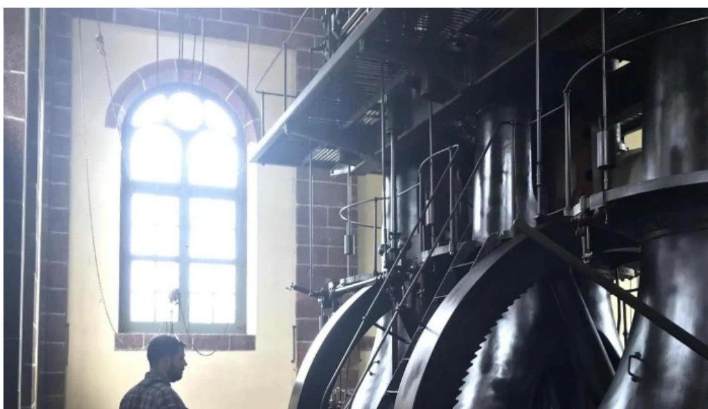
Planta potabilizadora de aguas corrientes ose promocion
