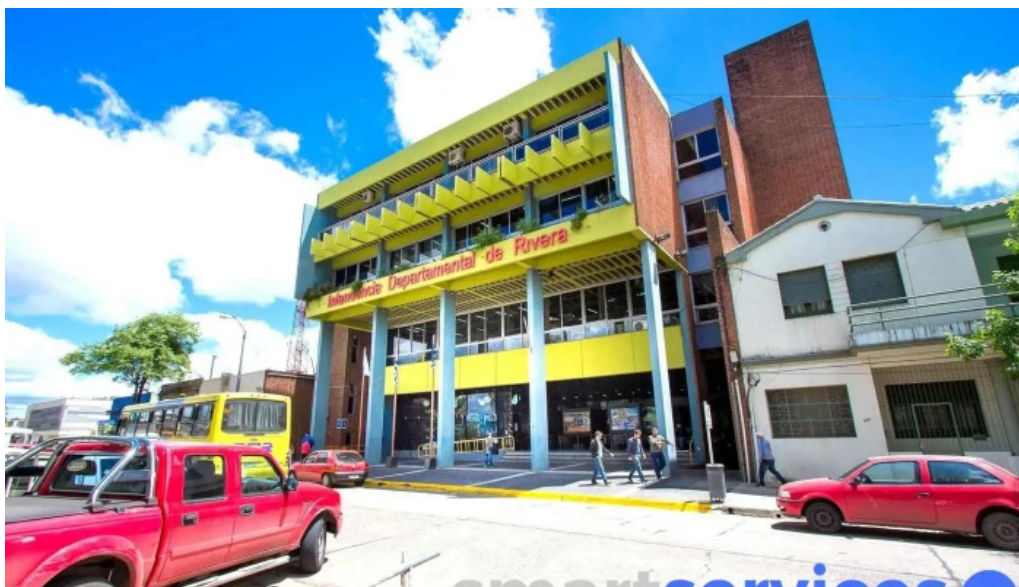
Intendencia departamental de rivera edificio
