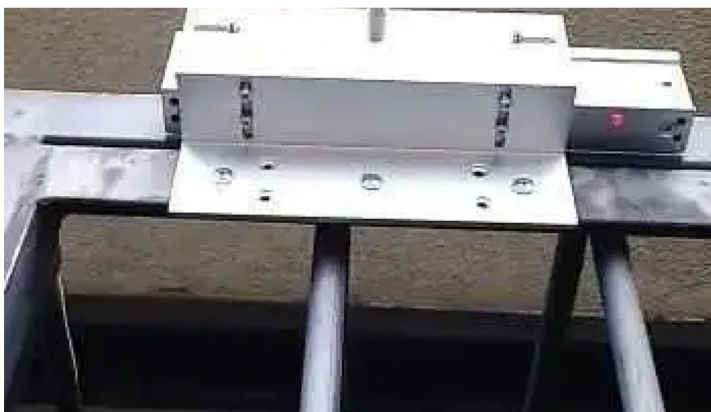
Cerrajería zorrilla interior
