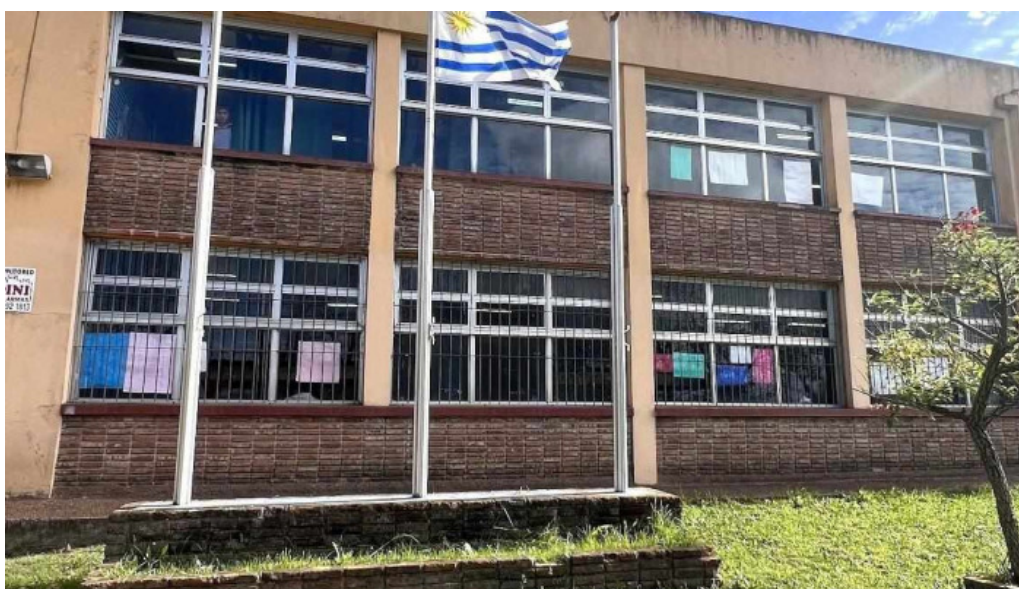
Liceo de progreso horario
