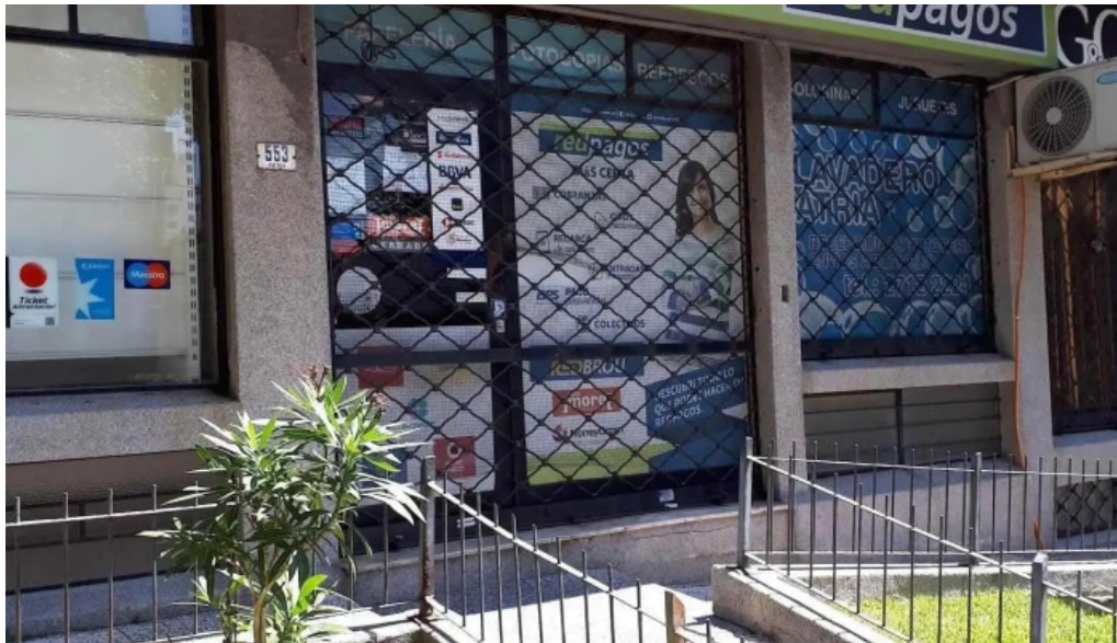
Redpagos torre patria exterior
