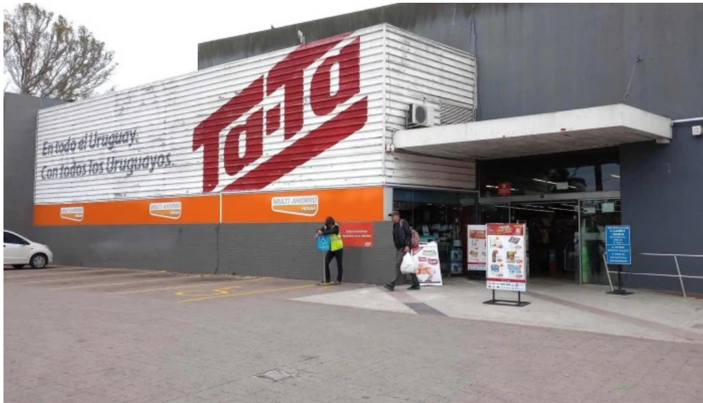
Redpagos multiahorro 13 exterior
