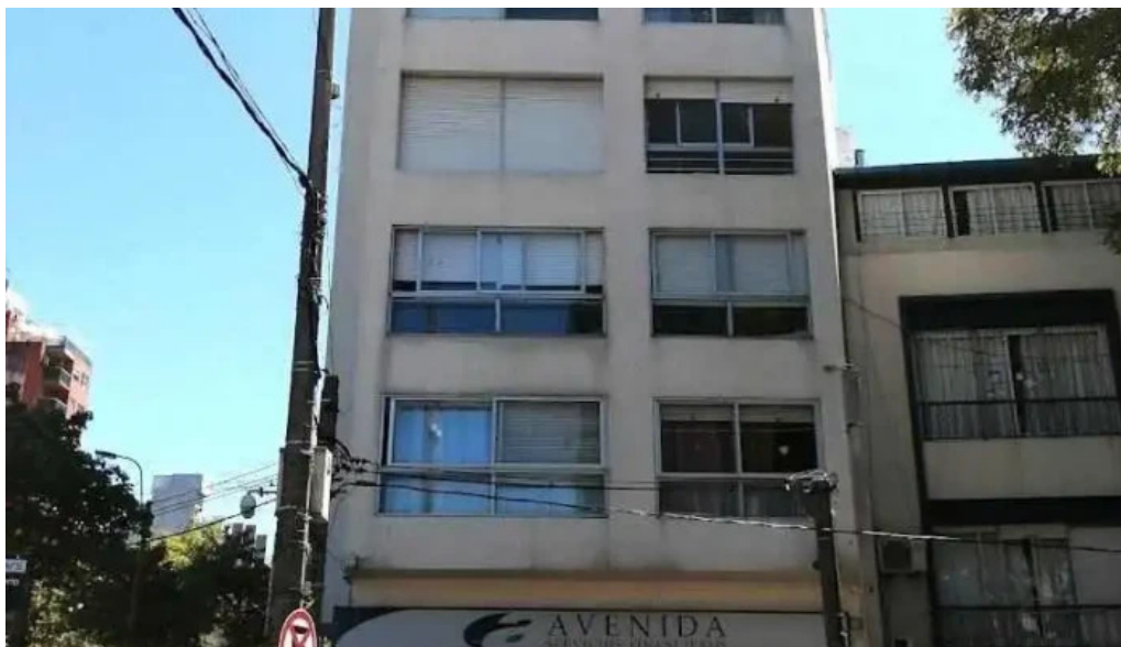
Cambio avenida montevideo
