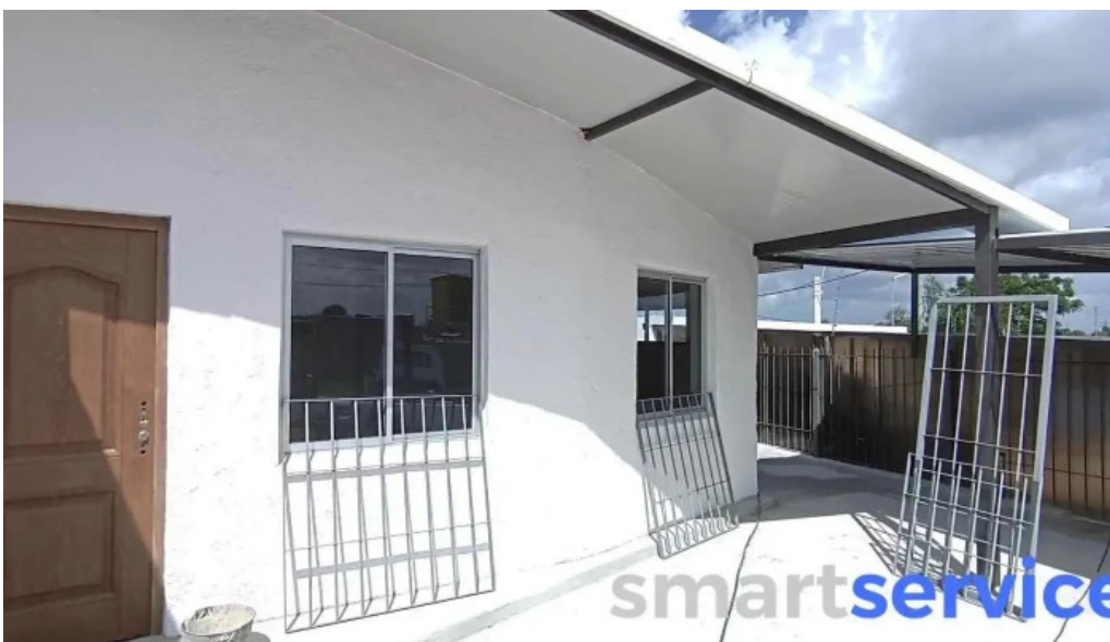
Herreria reparaciones varias recientes
