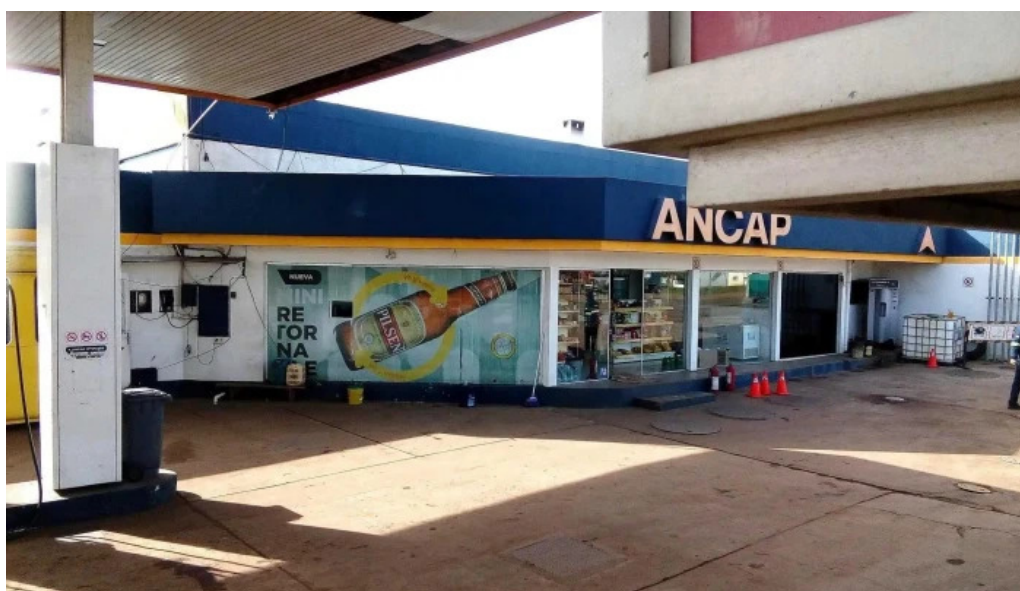
Estacion ancap exterior
