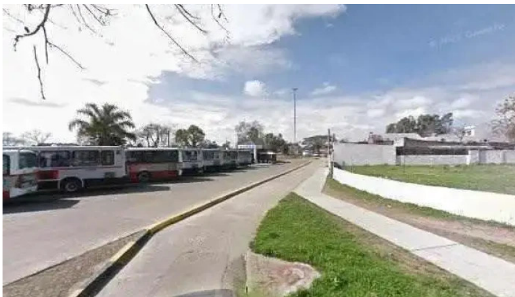
Terminal paso de la arena stm fotos
