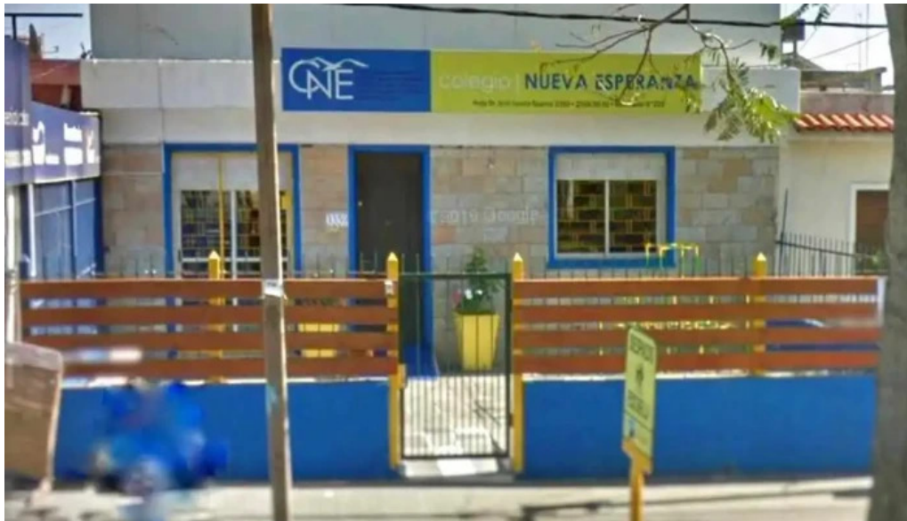
Colegio nueva esperanza edificio
