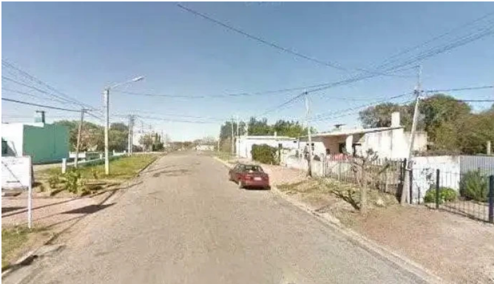
Electricidad automotriz torres electricista
