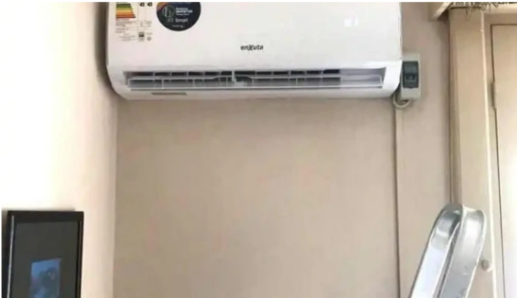
Er electricidad y aire acondicionado electricidad
