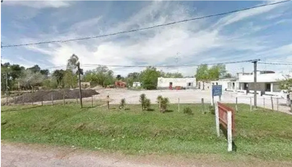
Instalaciones electricas uv electricista
