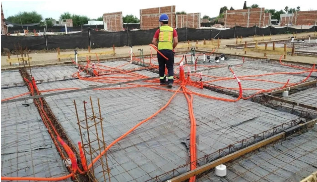
Rs electricidad electricidad
