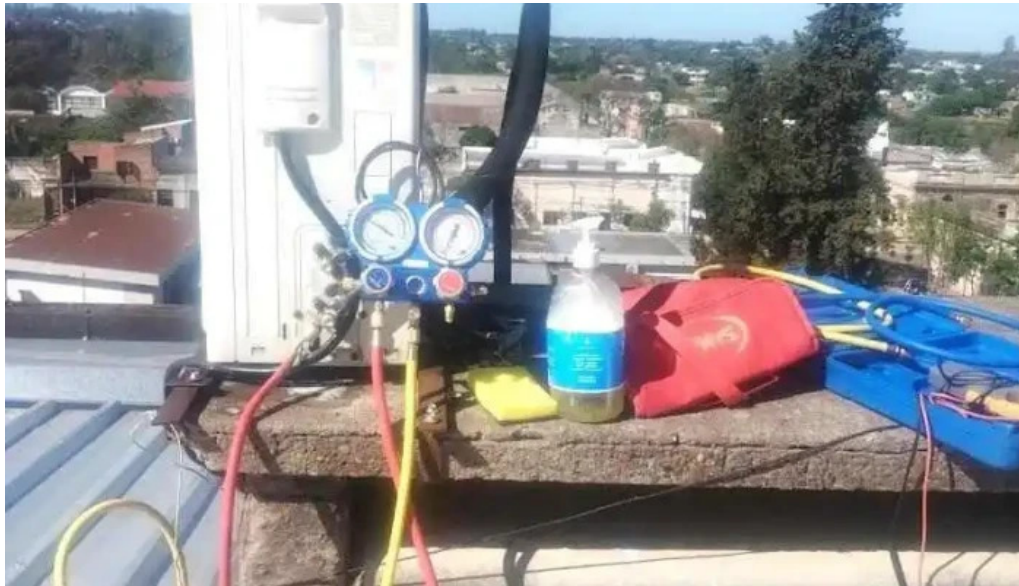
Electricidad san pedro salto
