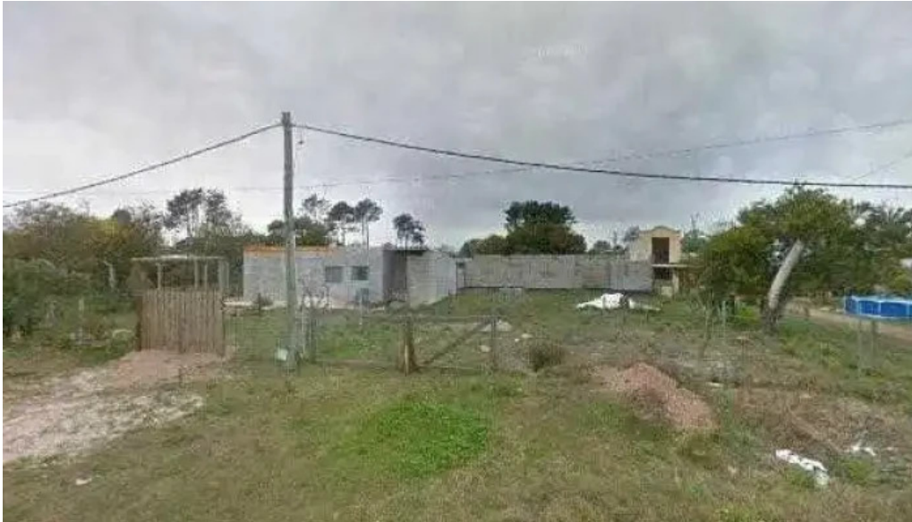
Eda instalaciones electricas instalaciones
