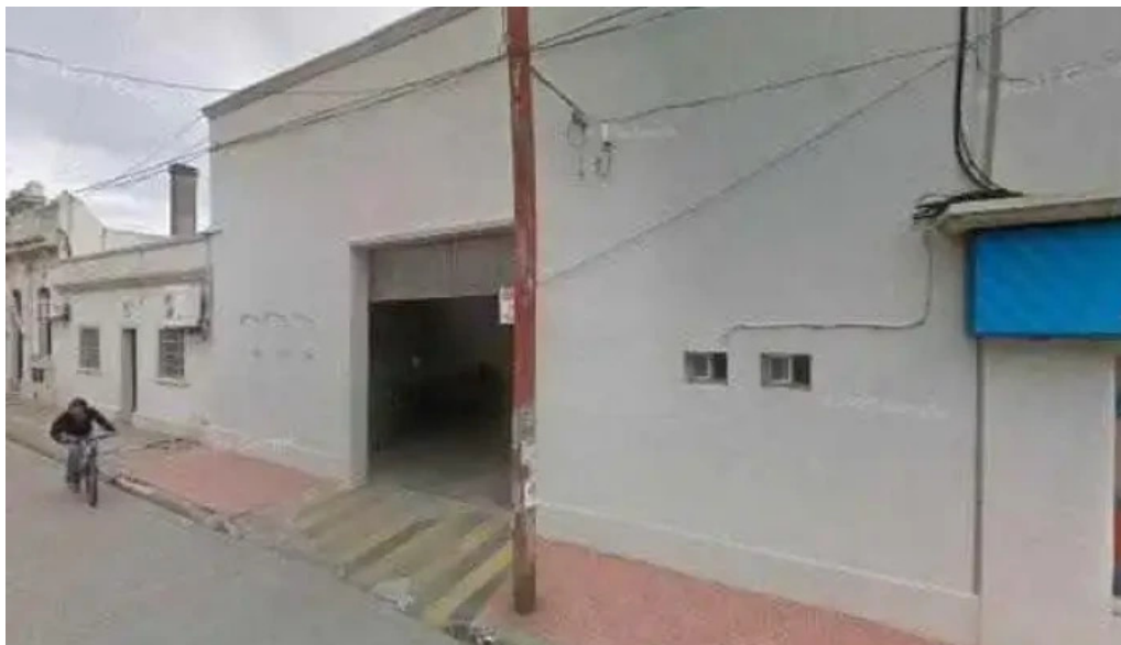
Wilson electricidad servicio
