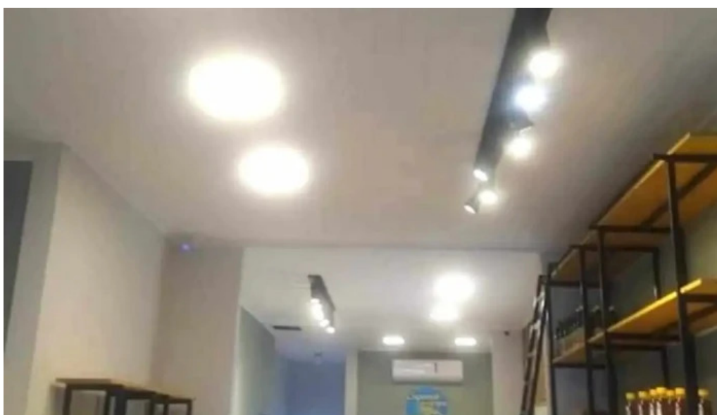
Electricista y plomero del propietario
