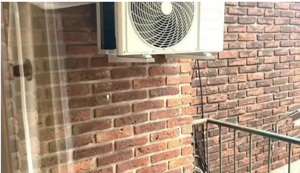
Electricidad ibarra rivera
