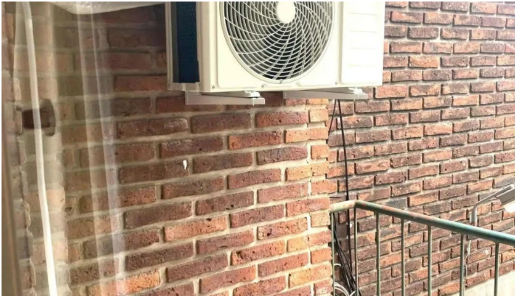
Electricidad ibarra servicio
