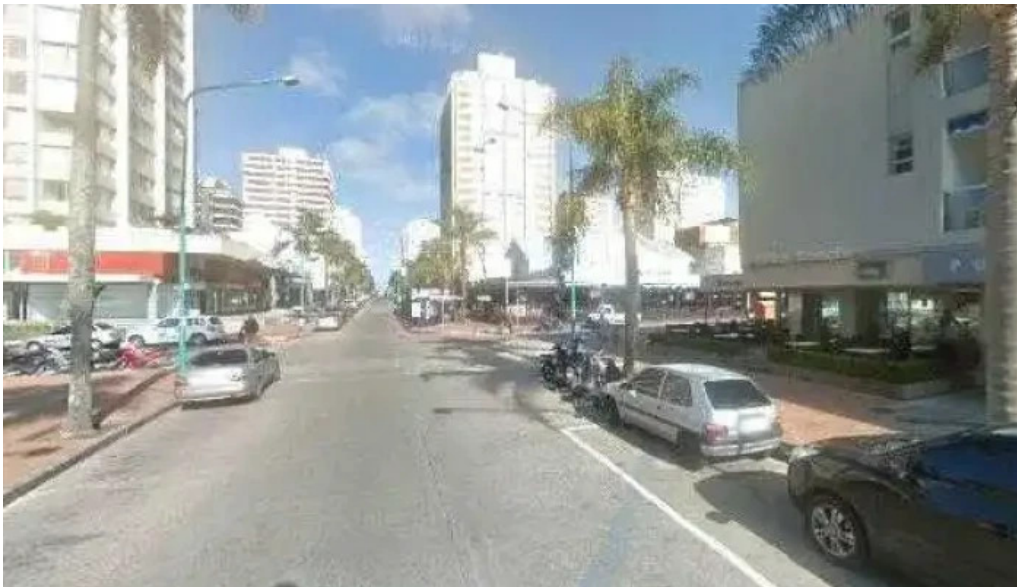
Syma instalaciones electricas instalaciones
