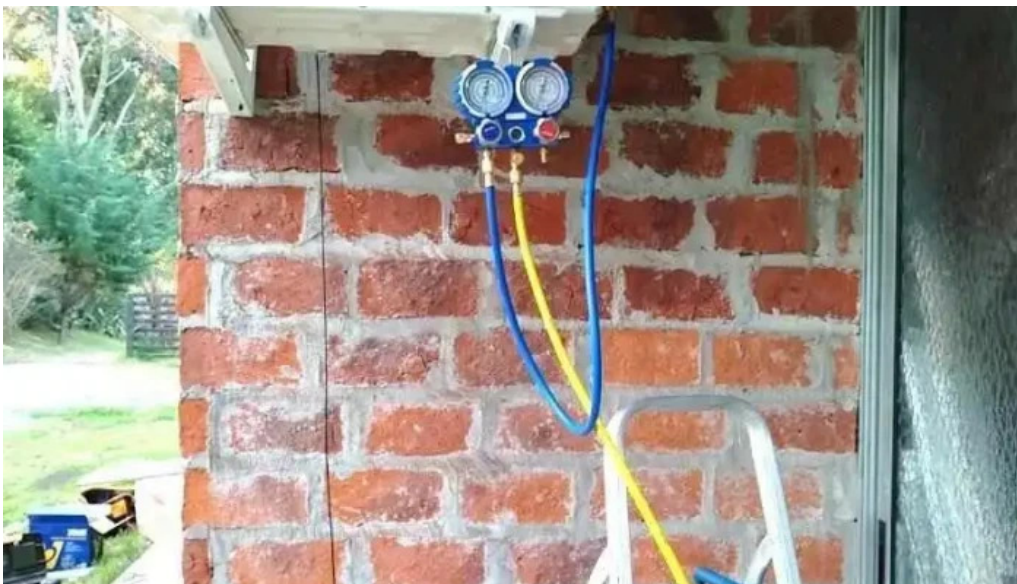
Electricista e instalacion aire acondicionado y camaras de seguridad punta del este punta del este
