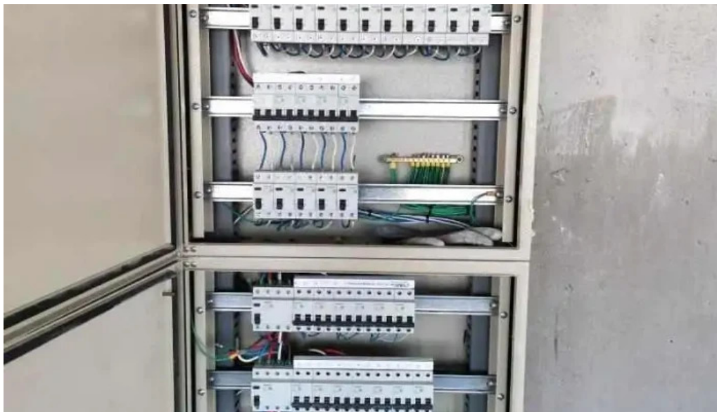
Electricista progreso electricista
