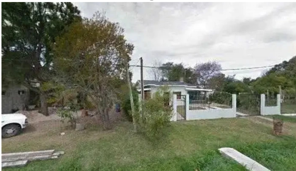
Ricardi instalaciones electricas ricardi
