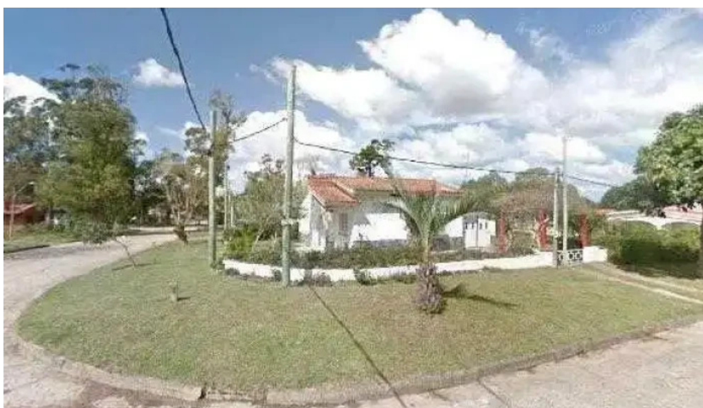
Electricista tecnico instalador autorizado por ute eduardo esnal eduardo
