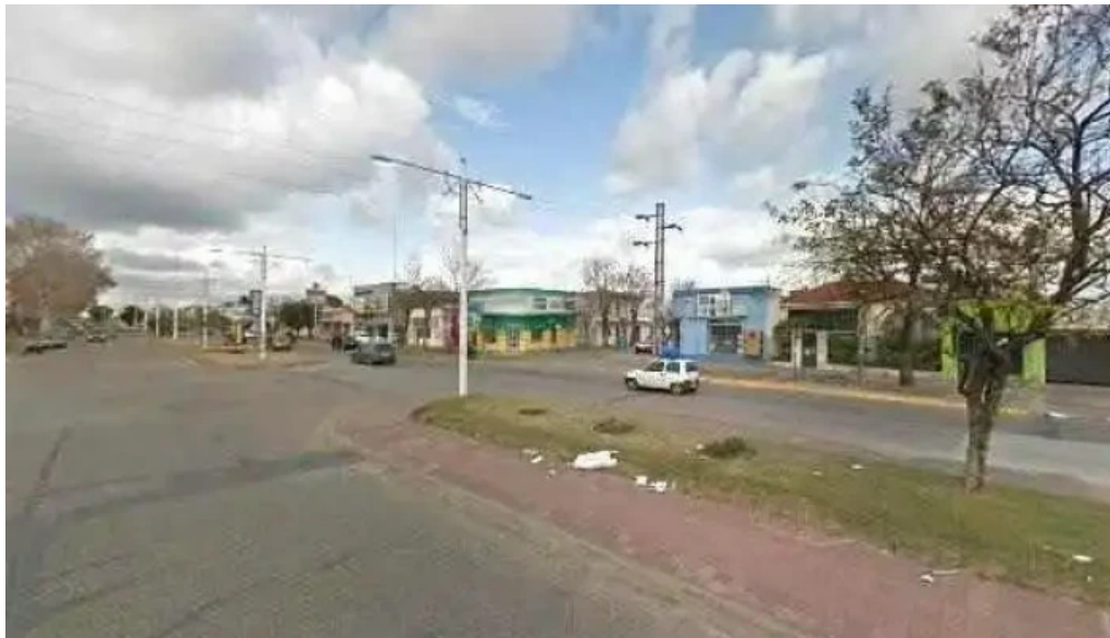
Electrica paysandu electricista
