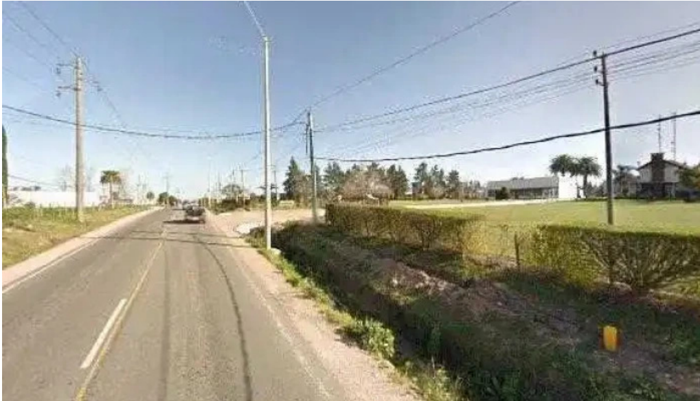
Durazno ingenieria electricidad durazno srl centro logistico pando electricidad
