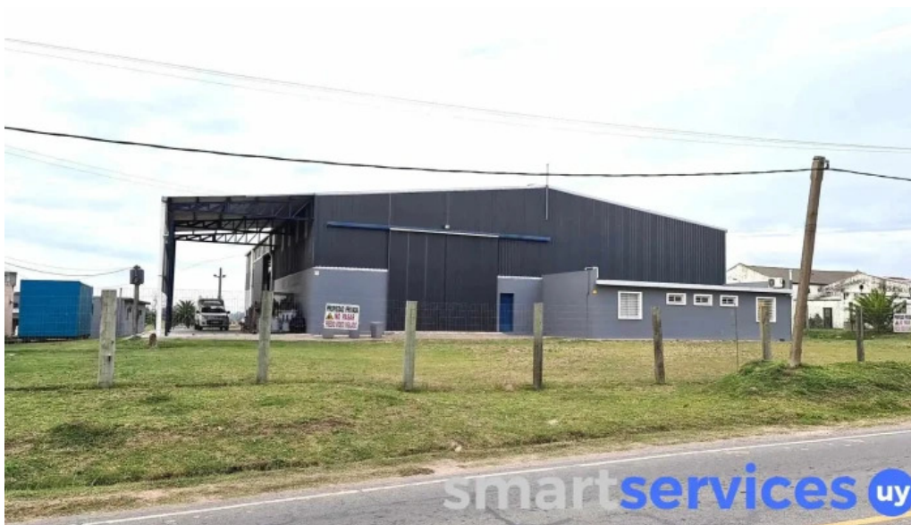
Durazno ingenieria electricidad durazno srl centro logistico pando hormigon
