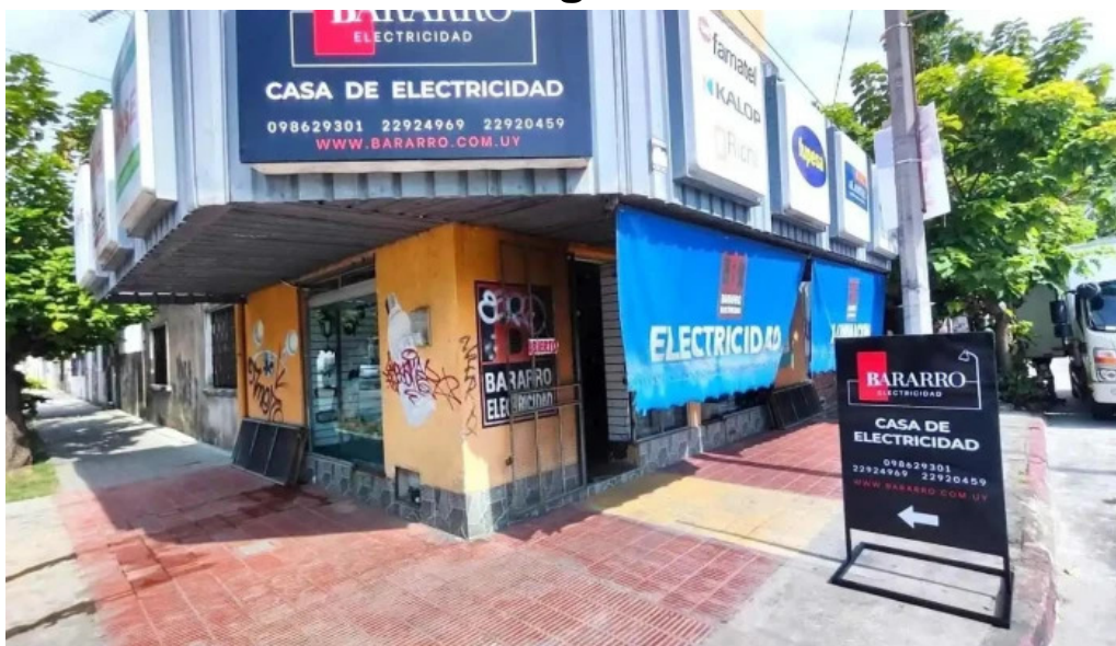
Bararro electricidad pando
