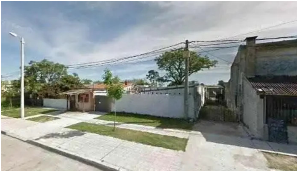
Tecnico electricista montevideo
