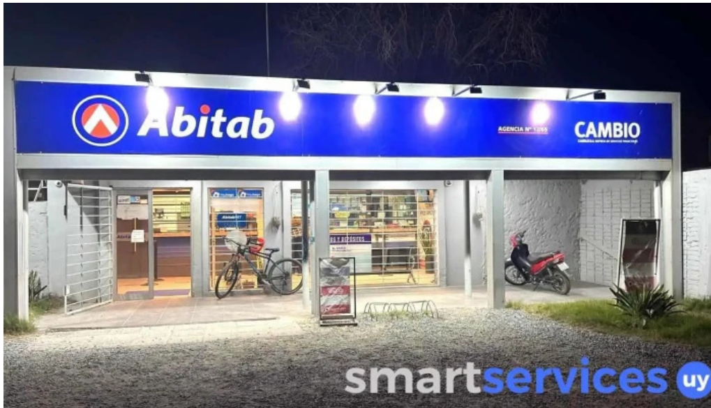
Sdi servicios e instalaciones exterior
