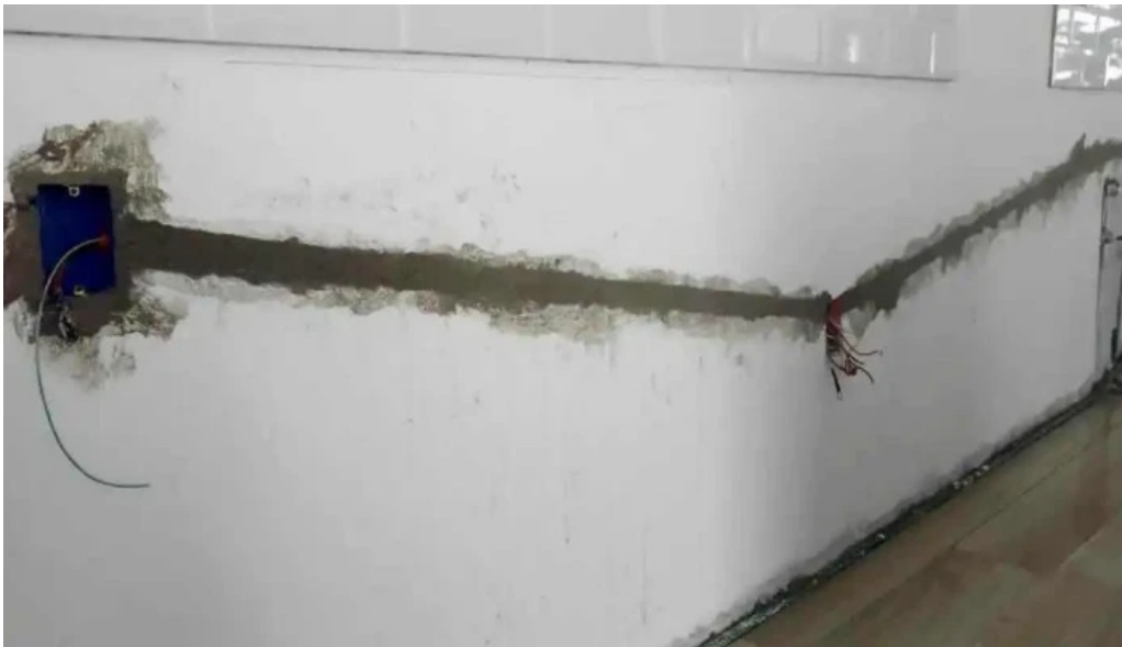
Safe instalaciones instalaciones
