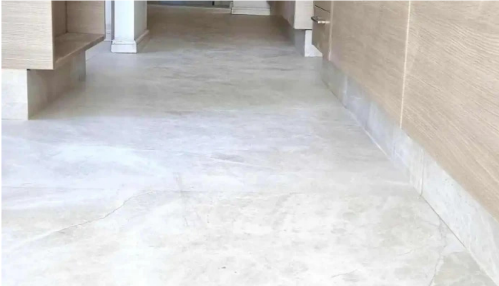
Reformas construccion herreriayeso electricidad pintura 094 784 708 interior
