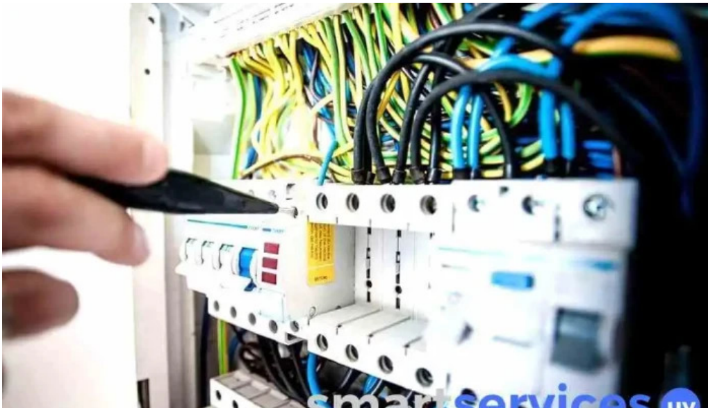
Mg electricidad uy del propietario
