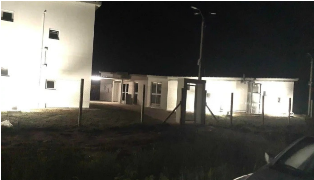
Jd electricistas exterior
