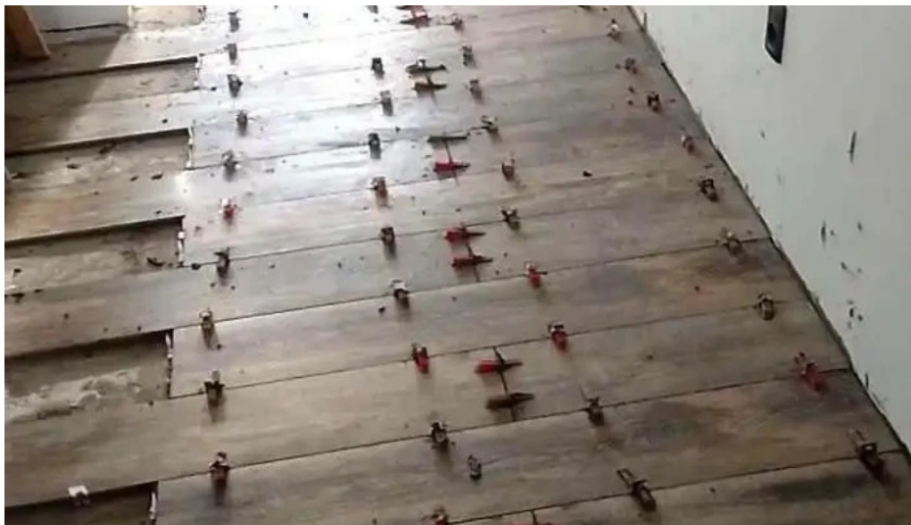
Glp construcciones reformas de bano y cocina albanileria sanitario electricista pintor interior
