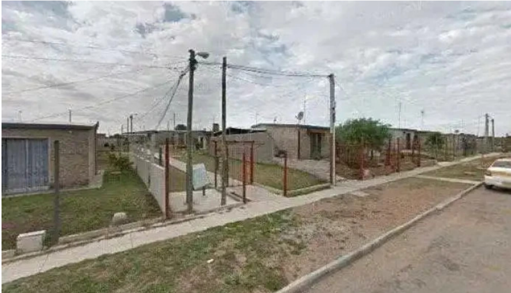
Electricista autorizado autorizado
