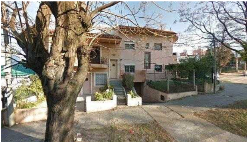
Ada servicios electricos servicios
