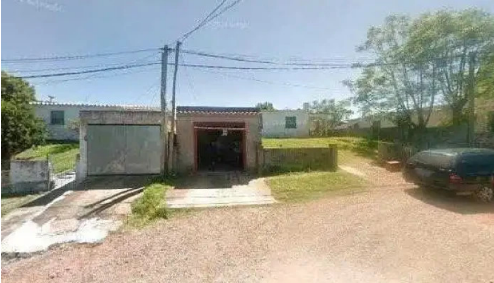
Electricidad fernandez cota electricidad
