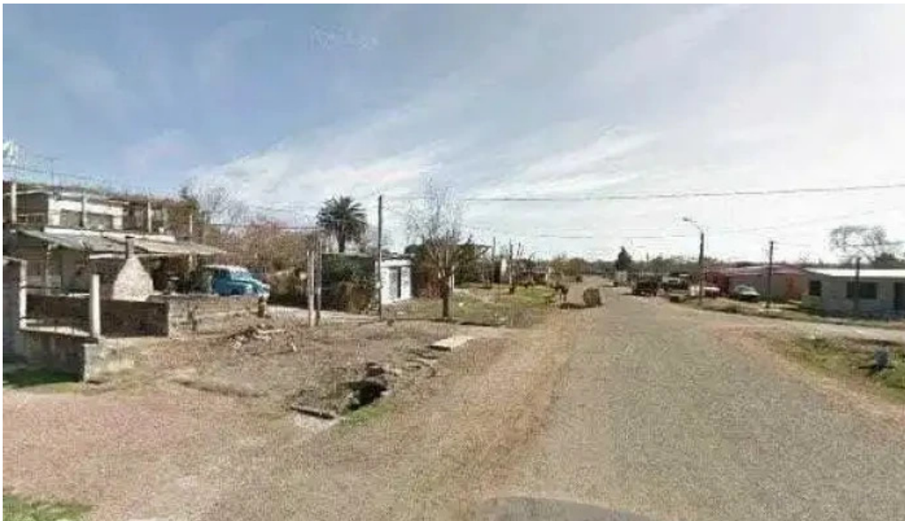
Amplificaciones audio e iluminacion instalaciones electricas piedras
