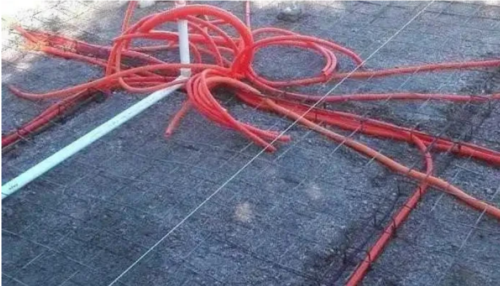
Amplificaciones audio e iluminacion instalaciones electricas las piedras
