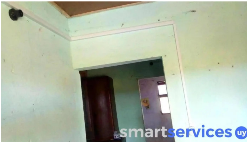
Lumi instalaciones electricas y reparacion de electrodomesticos interior
