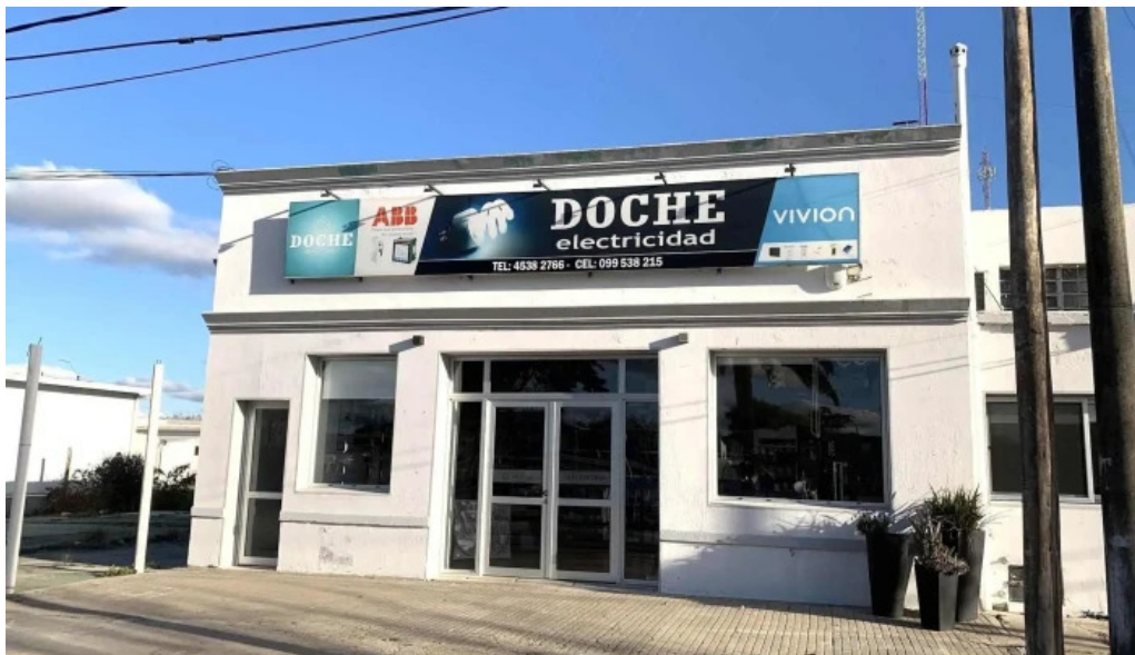
Doche electricidad exterior
