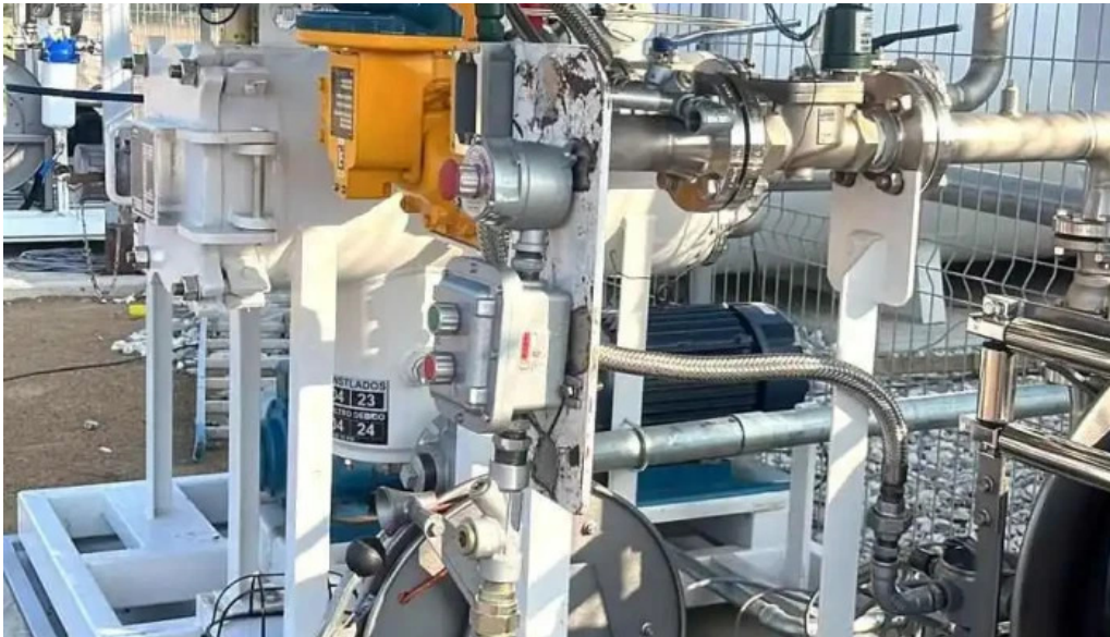
Darwin pereira electricidad construccion y aire acondicionado pereira
