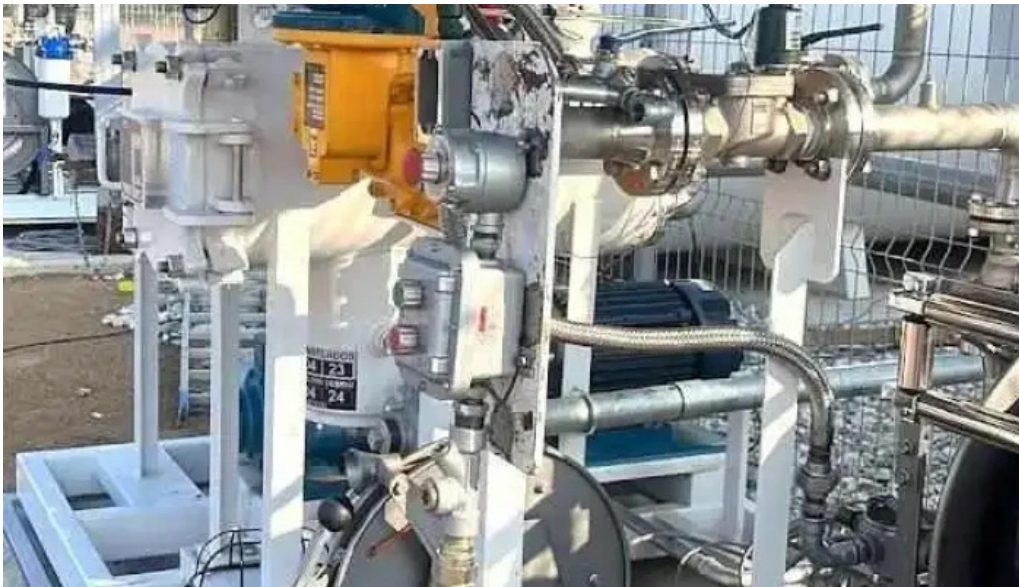
Darwin pereira electricidad construccion y aire acondicionado durazno
