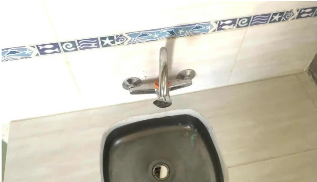
Elgarte reparaciones interior
