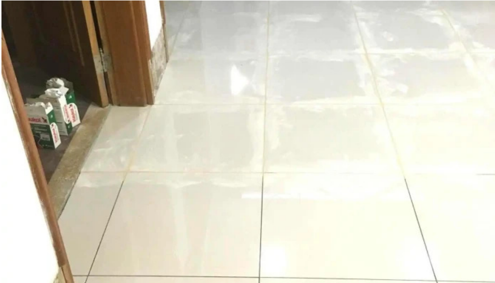
Elgarte reparaciones del propietario
