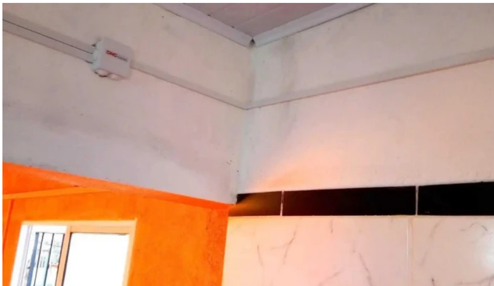
Electricista pl servicios generales firma autorizada por ute interior
