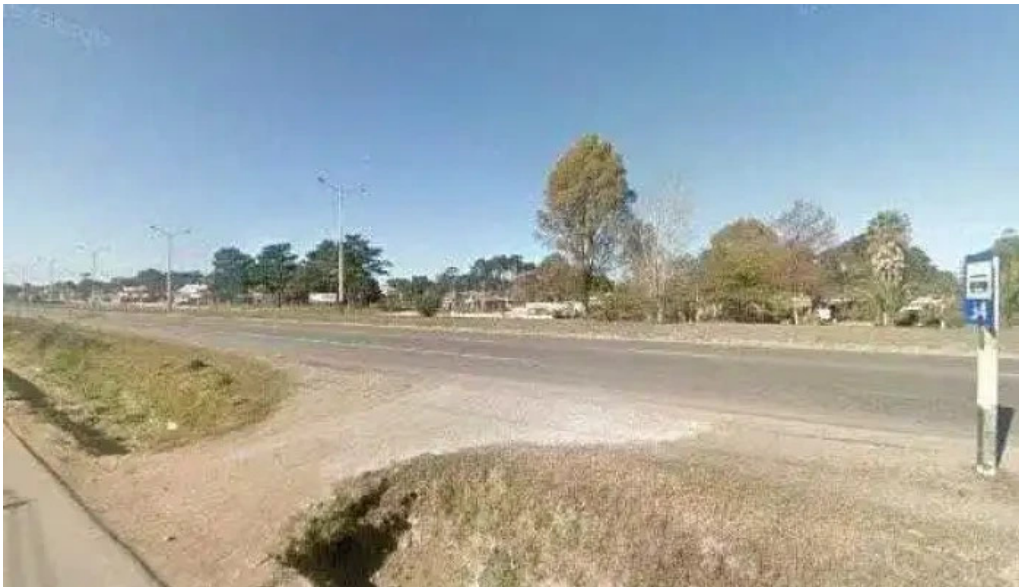
Ps iluminate electricidad electricidad
